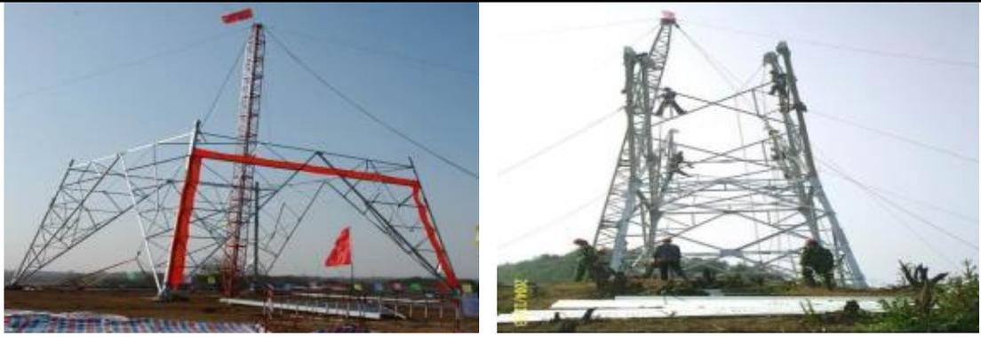
图 2-1 线路工程铁塔组立典型现场影像（示例）
