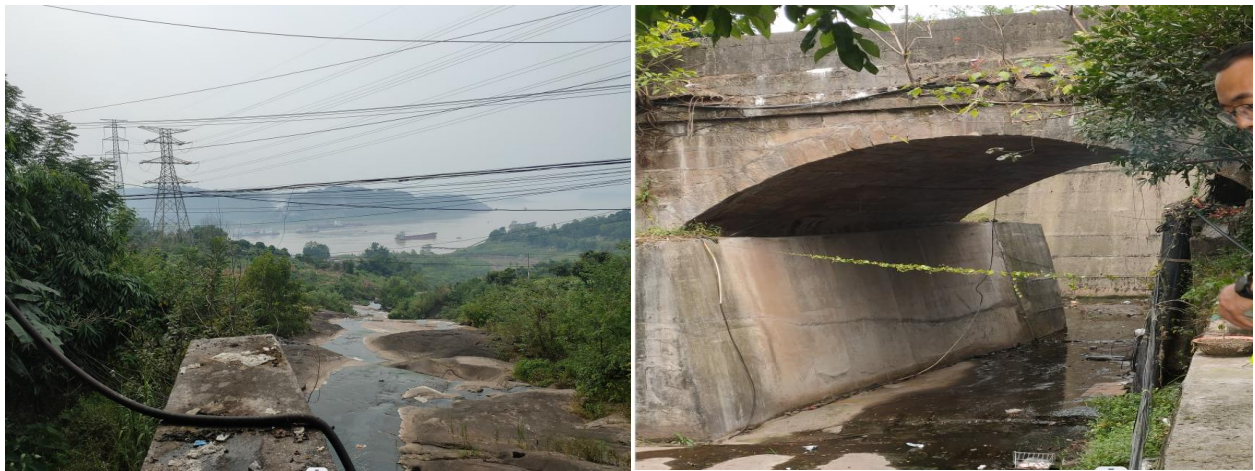
图 4.3-1 绩麻河埋管段河道现状图
