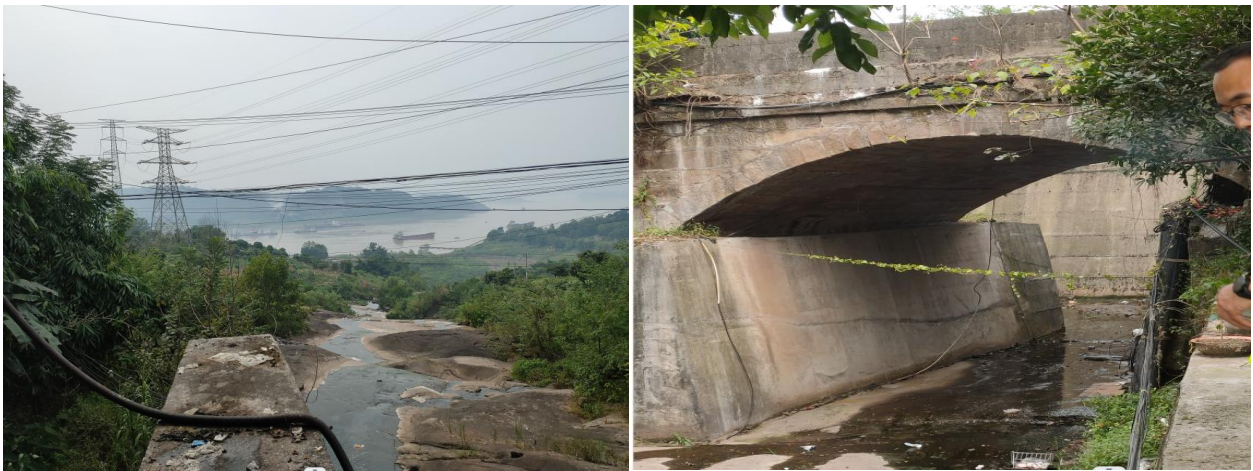
图 4.3-1 绩麻河埋管段河道现状图
