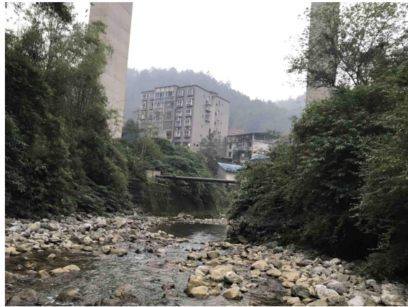
图 5.2-1 配水左支管（D40~D41 管段）跨越麻溪河处现场照片
