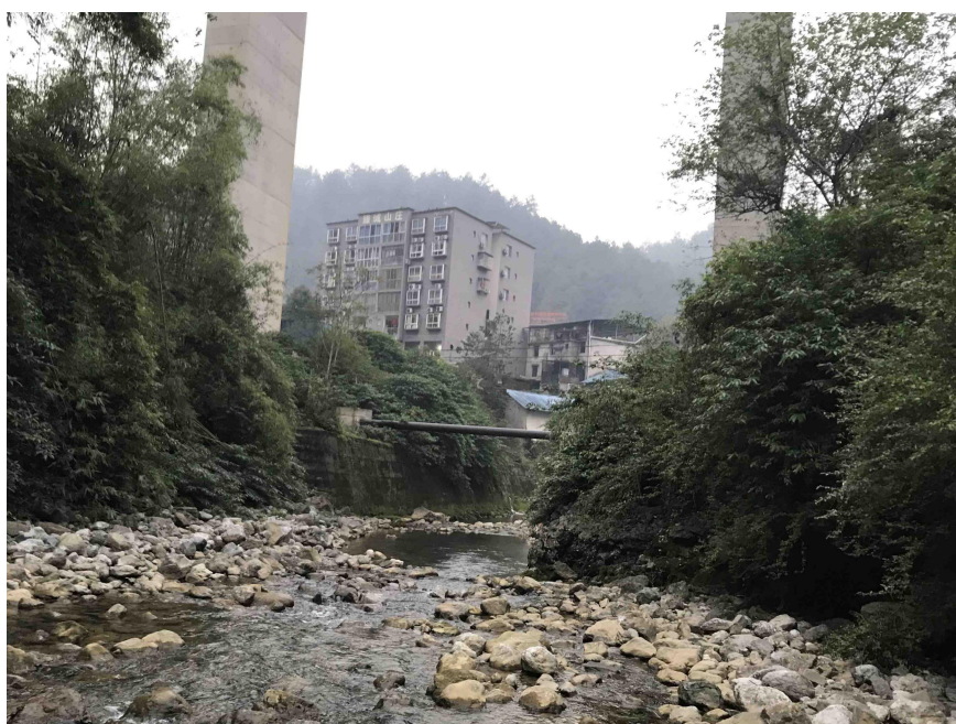
图 3.1-4 管道跨越麻溪河实景图
