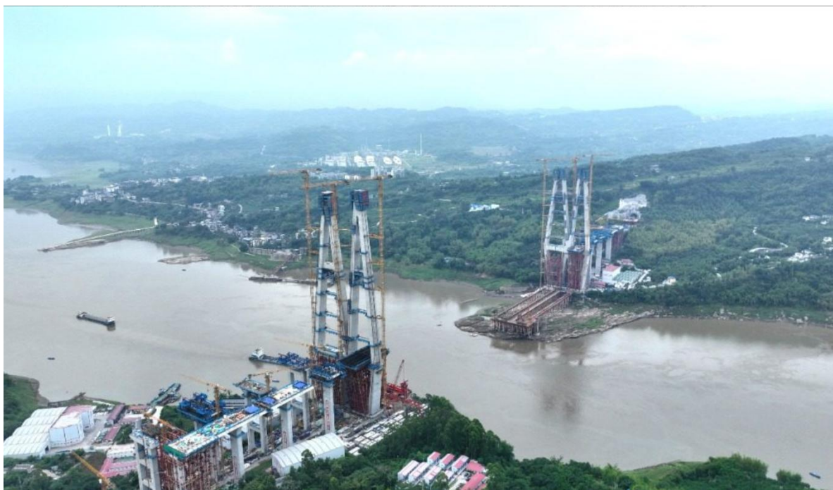
图 3.2.8-2 石沱长江大桥建设现状（2025.6）
