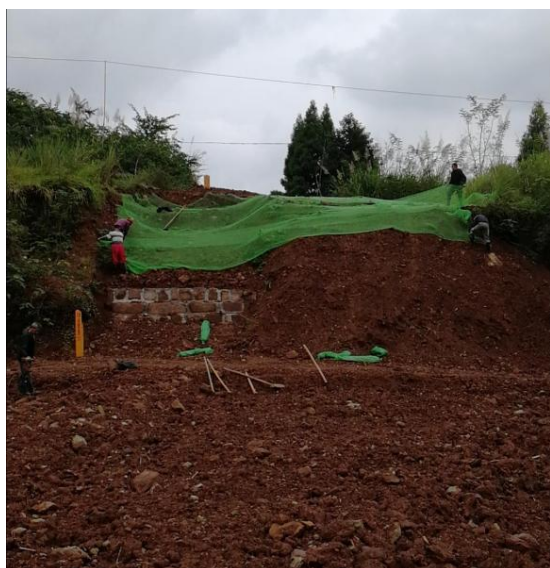
施工作业带彩条布覆盖过程
