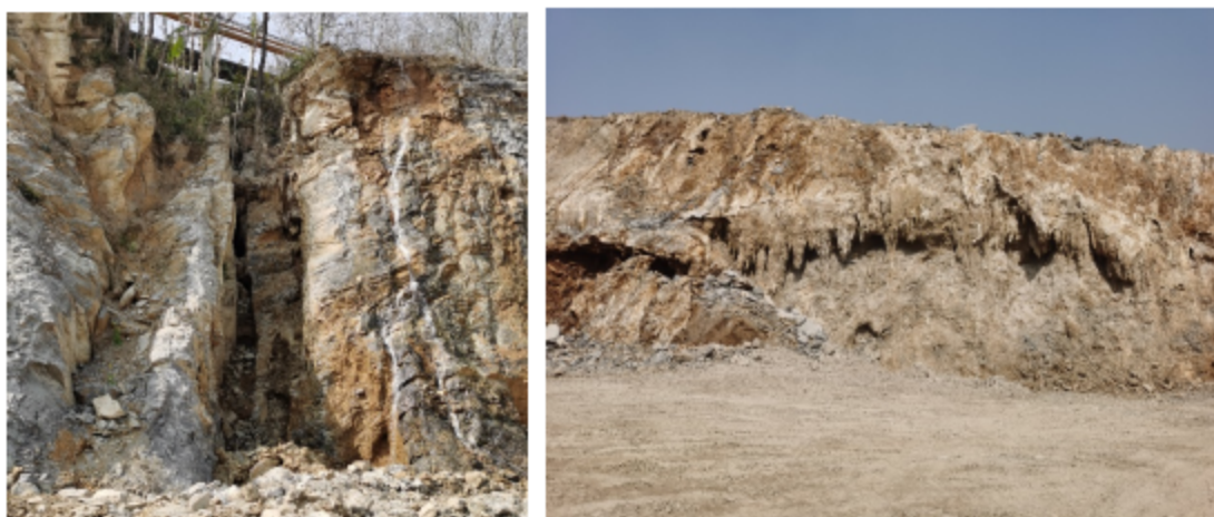
图 4.1.3-2 岩溶垂向岩溶裂隙
