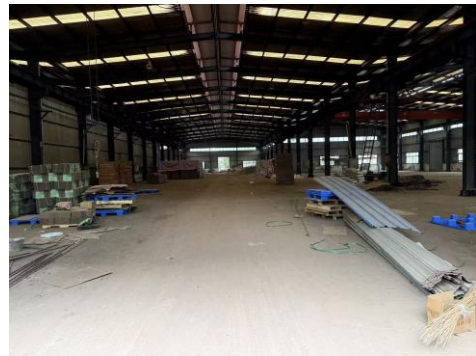
原重庆双维钢结构有限公司厂房内照片
