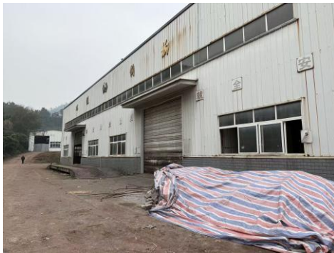
原重庆双维钢结构有限公司厂房
