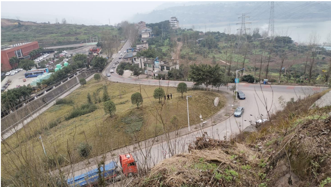
图 2-15 LK 线改路现场照片
