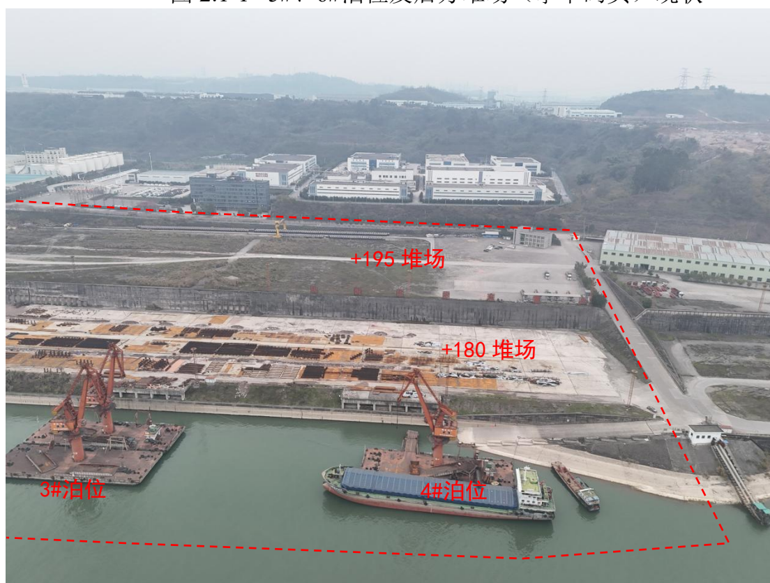
图 2.1-2 3#、4#泊位及后方堆场（鹤凤码头）现状
