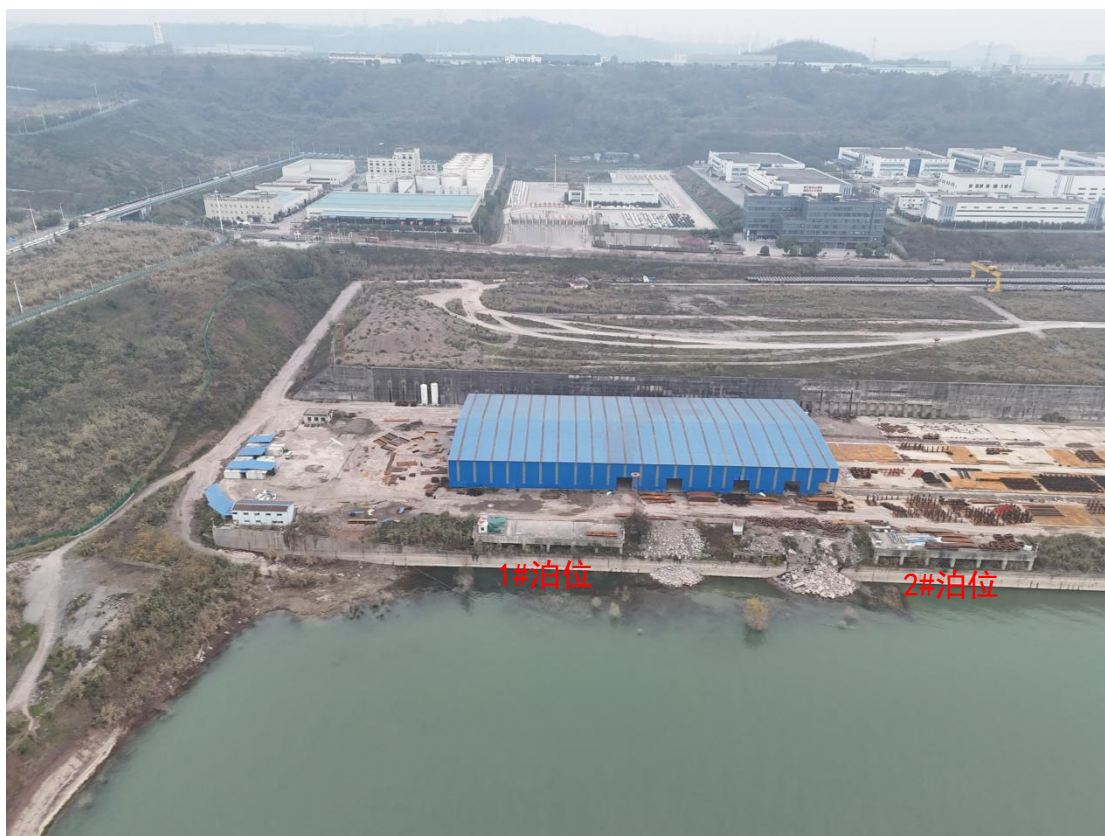
图 2.1-3 1#、2#泊位及后方堆场（鹤凤码头）现状
