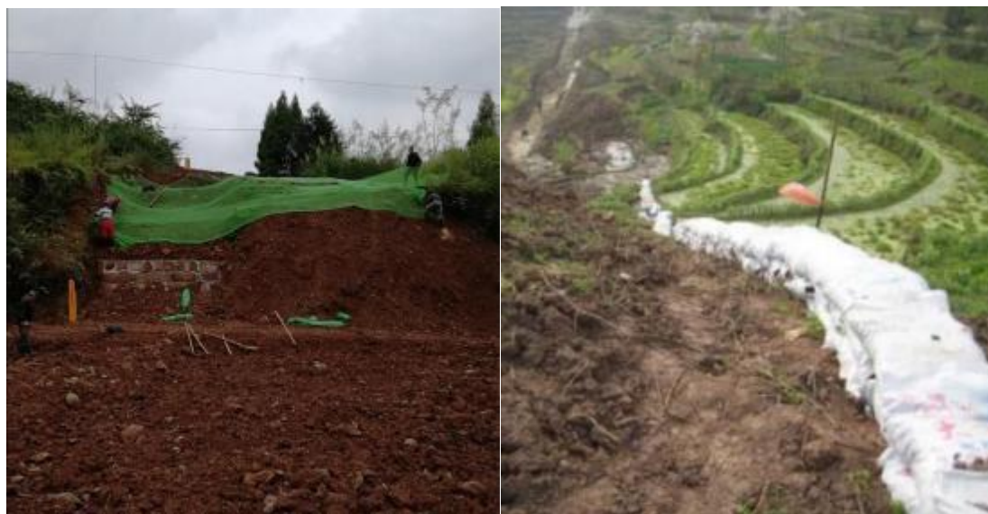
施工作业带彩条布覆盖过程
