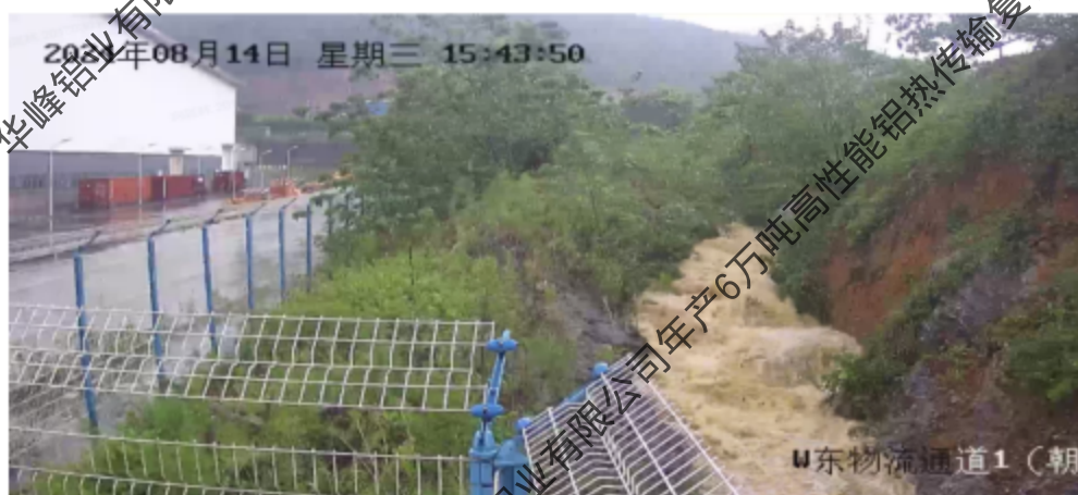
图 4.2.2-1 项目所在区域排洪沟现状图 (暴雨时监控画面)
