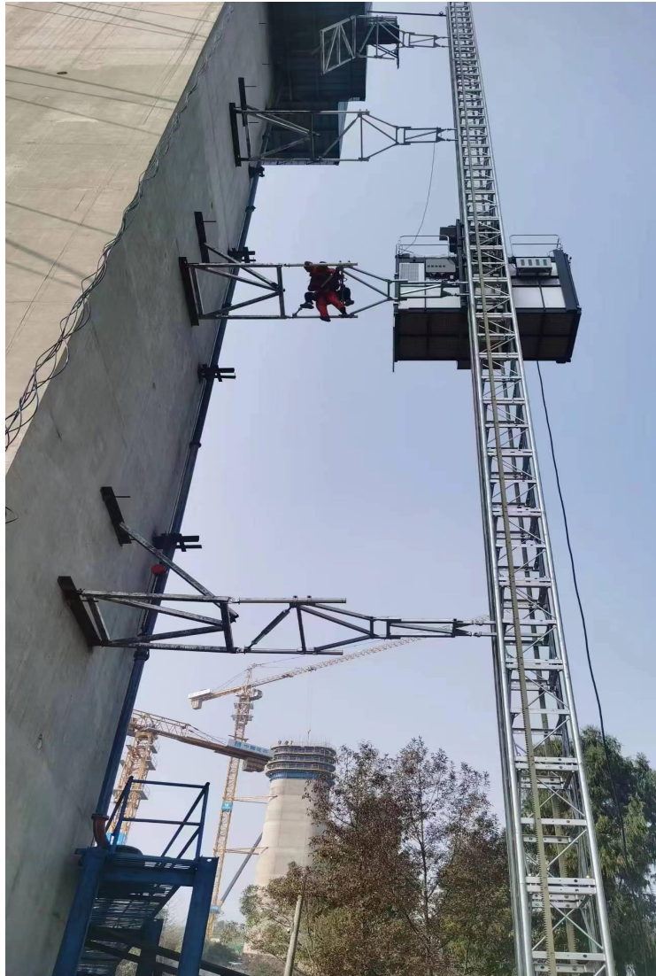
图 2 事故现场照片
