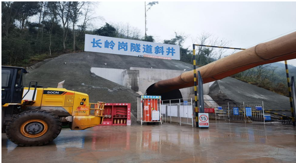
（图 1 长岭岗隧道斜井洞口）
