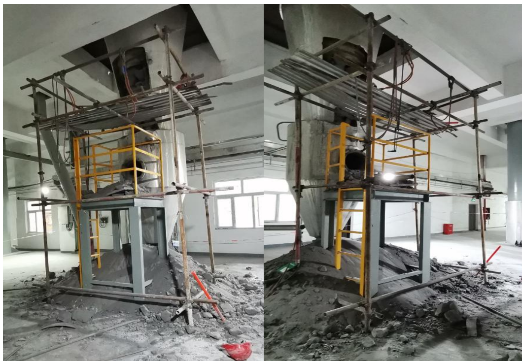
图4 脚手架操作平台
