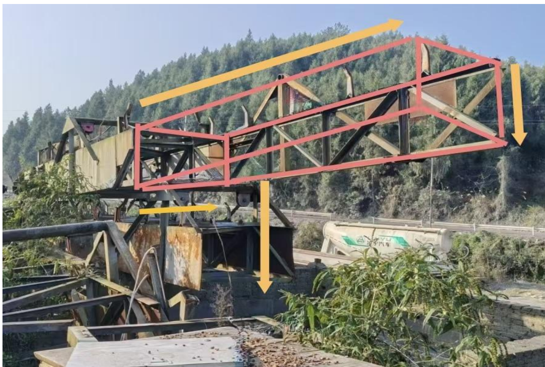
图 3 废传送带钢构机架已切割部分示意图
